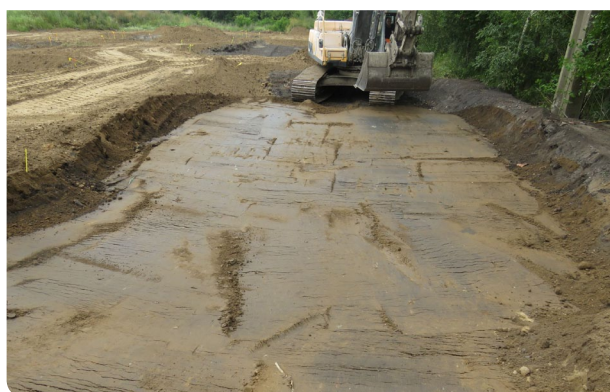
Placement d'argile sur une mare de compensation à Quaregnon
