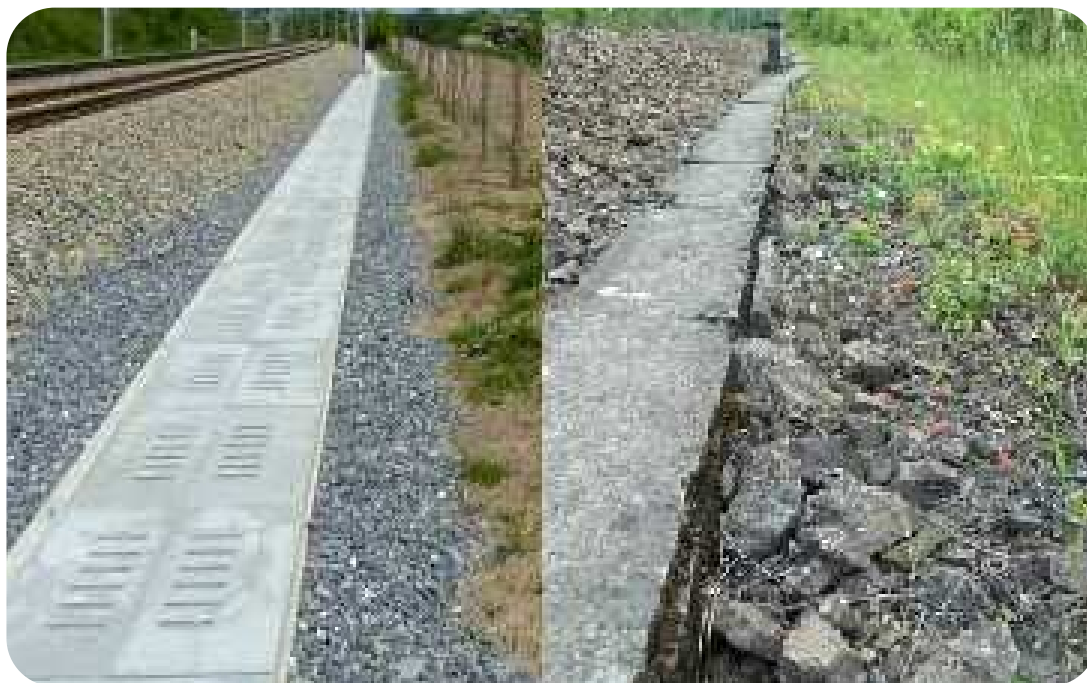
Fig. 4 : A gauche, couche de graviers initialement prévue en finition lors du remplacement des caniveaux. A droite, exemple d'enrochement proposé en lieu et place des graviers afin de reconstituer un milieu attractif pour les reptiles.
