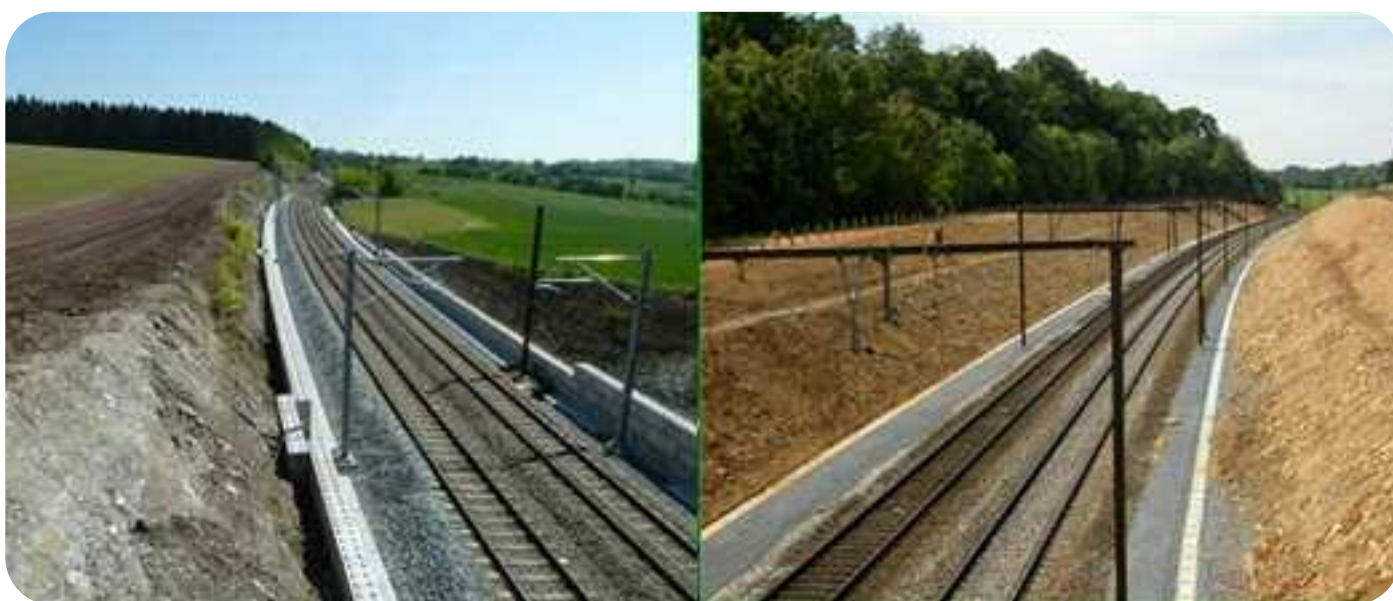
Fig. 3 : Tronçons récemment modernisés de la ligne SNCB 162 dans les régions de Neufchâteau et Arlon
