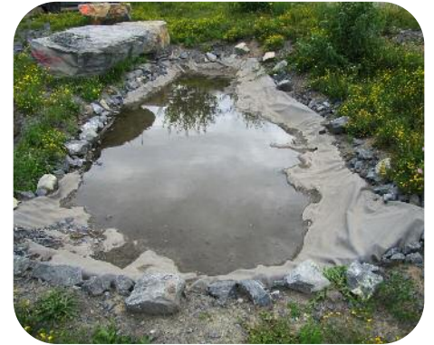
Mare bâchée et alimentée par un tuyau recueillant les eaux de ruissellement de deux pistes du terril
