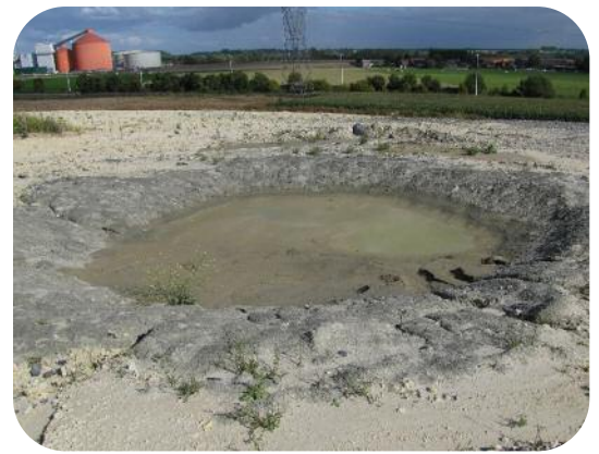
Colmatage de la mare par des argiles lessivées après une pluie importante
