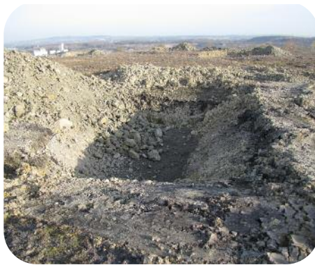
Creusement de la fosse avant l'apport de 80 cm d'argile
